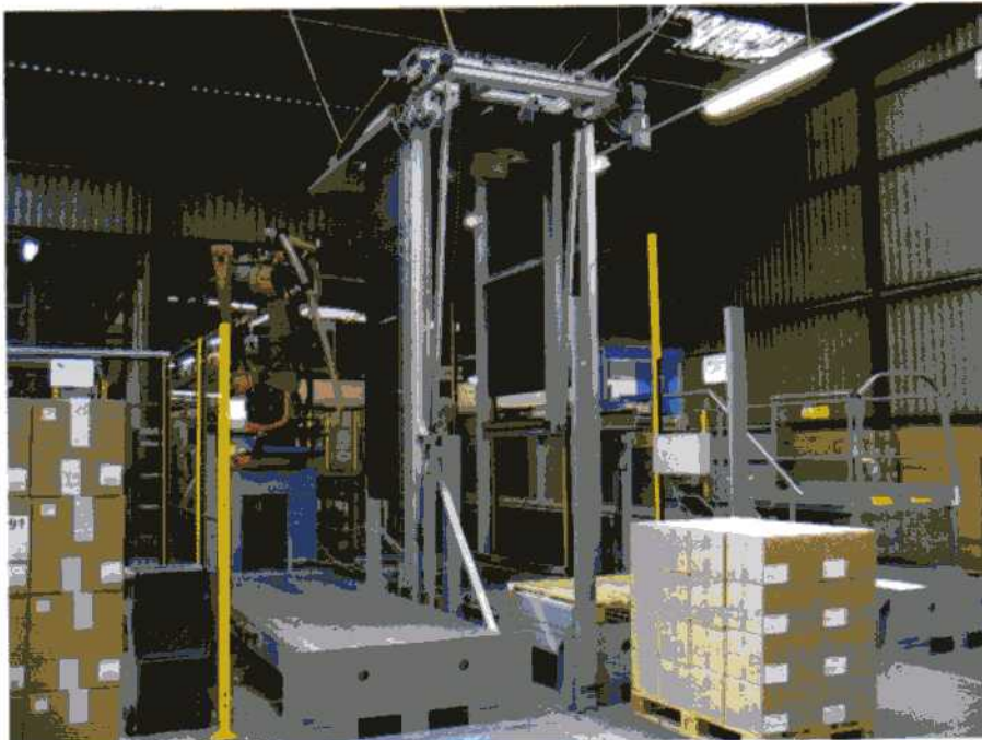
Pour automatiser le déchargement des palettes contenant les cartons de produits à traiter, Ionisos a fait installer un portique intégrant une caméra, un laser et un télémètre. Grâce aux informations fournies par cette solution de vision 3D, le robot connaît la position des cartons qu'il doit saisir et déplacer.
